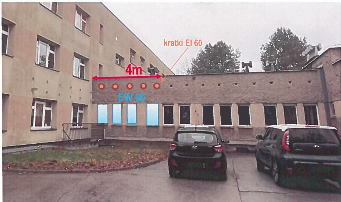
Fotografia 2. Sposób zabezpieczenia łącznika w pasie 4m od strony budynku szpitala
